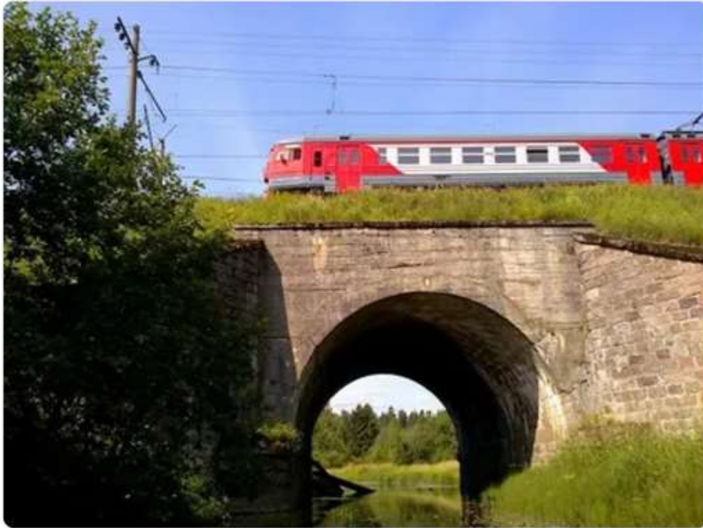
ж/д мост через реку Суйду между п.Суйда и п.Прибытково, Октябрьская ж.д.
